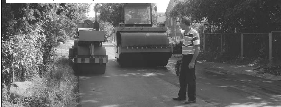
Ремонтные работы на ул. Эльхотовской
