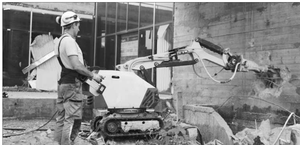
Пробный запуск робототехники для демонтажа недостроенного здания на набережной р. Терек
