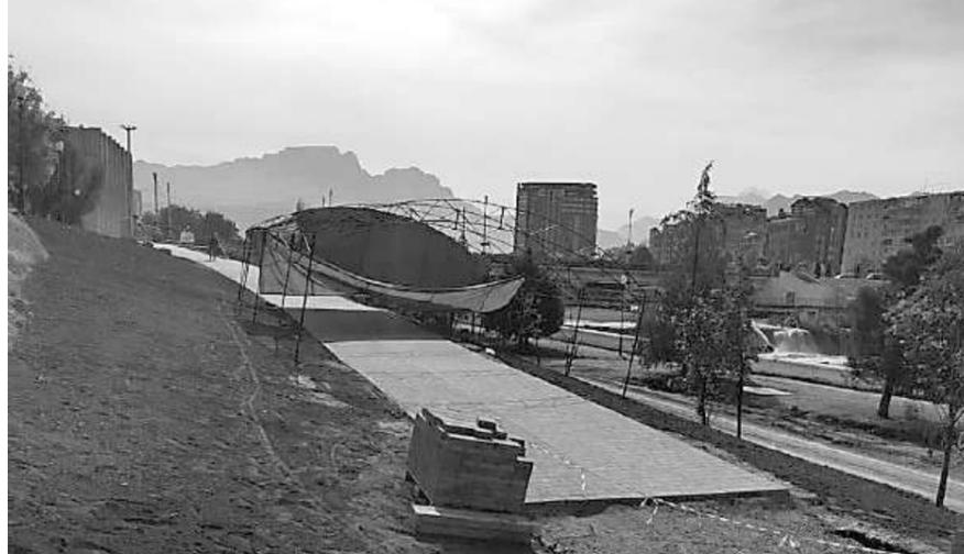
Также, согласно требованиям ГО-Ста, здесь обустраивается пандус для маломобильных граждан. Плавный спуск будет чередоваться с удобными площадками. На всем протяжении пандуса будут установлены поручни. Работы по укладке брусчатки подходят к завершению, на 80% территории приведена в порядок газонная часть.
